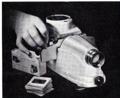
**6. Introduire la diapositive suivante** dans le passe-vues, pousser la bouton grenat à fond à gauche et le ramener à droite. La seconde vue pousse la première (qui passe à gauche du projecteur) et la remplace sur l'écran. La première vue tombe d'elle-même à gauche du projecteur, quand on pousse la troisième en position ; il est commode de placer une petite boîte à cet endroit pour recevoir les vues projetées.
